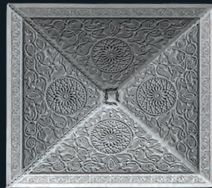
Bóveda P Compuesta por 4 piezas de 140cm de largo x 78,5 cm alto
